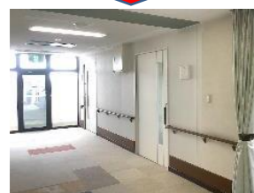
3階居室完成後
