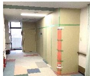
3階居室工事中の養生壁
